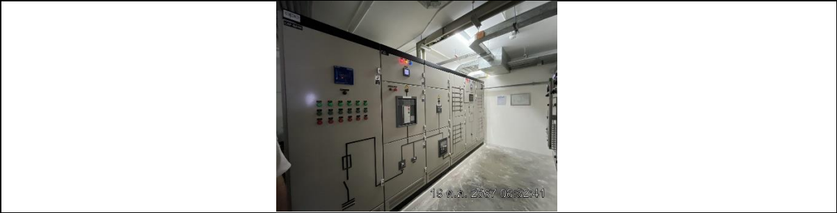
รูปที่ จ7.36 สวิตช์บอร์ดแรงสูงชนิดติดตั้งภายในอาคาร
