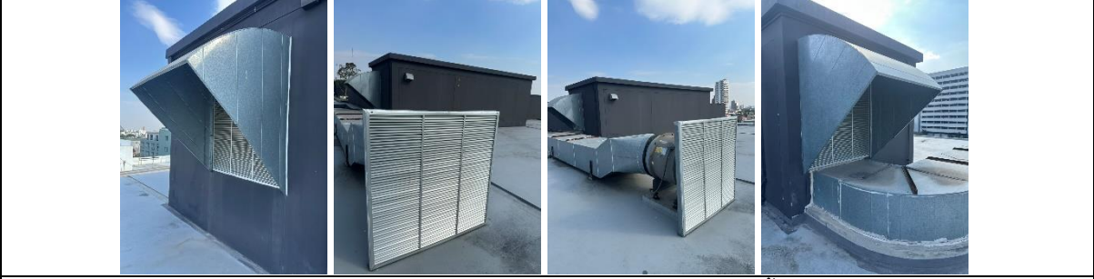
รูปที่ ผ7.75 ระบบระบายควัน (Smoke Exhaust) ที่บริเวณชั้นดาดฟ้า
